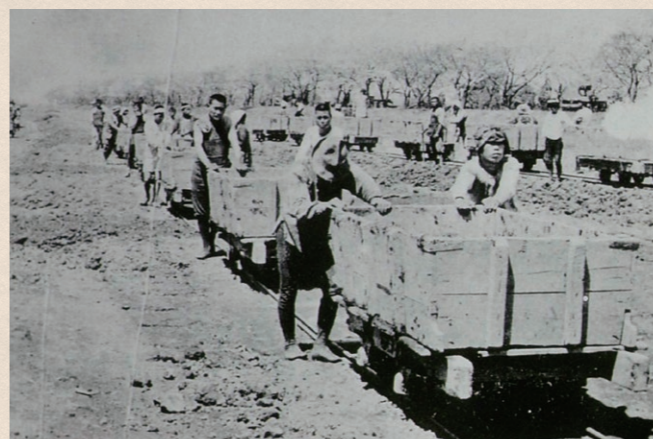
◀人力掘削の様子(土運搬作業)
