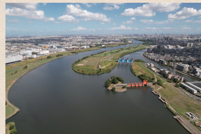
▲現在の荒川放水路(空撮)
